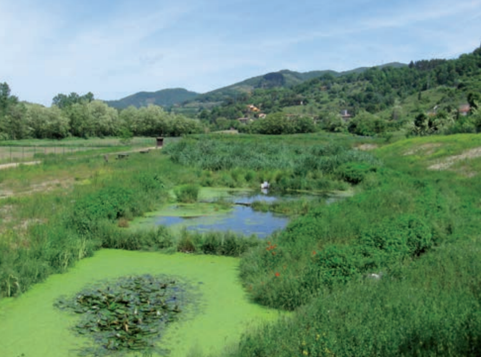
Figura 1 Impianto di fitodepurazione al servizio del Comune di Dicomano (Firenze), da 3.500 a.e.
