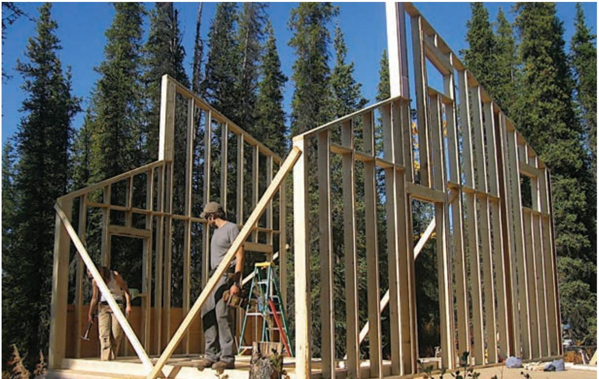
La parete a telaio (Balloon frame) prevede una struttura a montanti e traverse in legno massiccio (Climatikasa)
