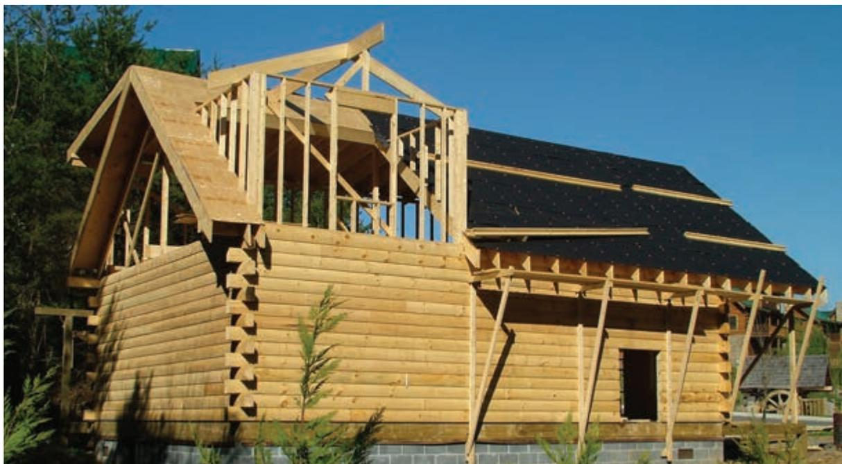
Il Blockhaus è un sistema costruttivo basato sull'impiego di tronchi di varie dimensioni sovrapposti
