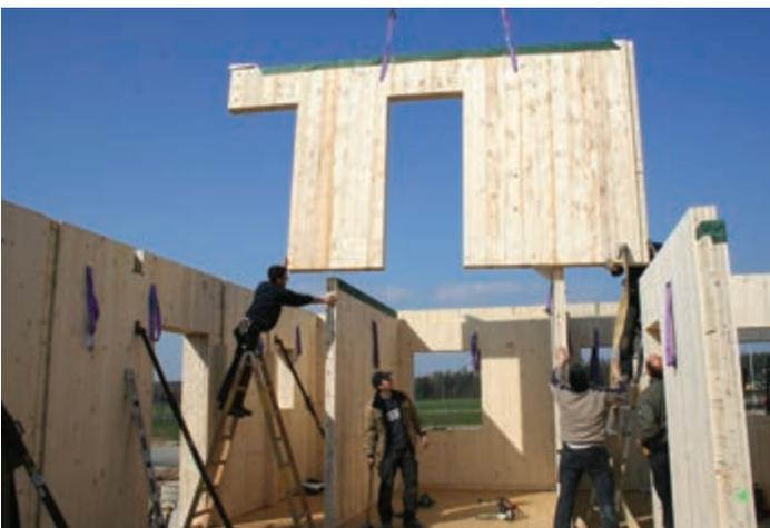
Montaggio di pareti X Lam (Löser - Schwarzott)
